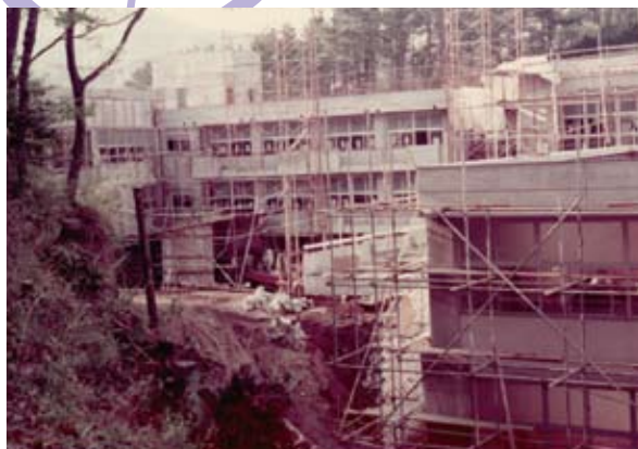
工事中の旭小（昭和47年）
